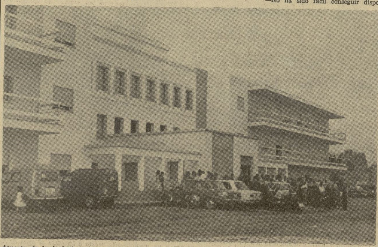
Aspecto de la fachada principal del nuevo asilo de ancianos de Motril, inaugurado oficialmente el pasado día 5. — (Foto VALDIVIESO)
