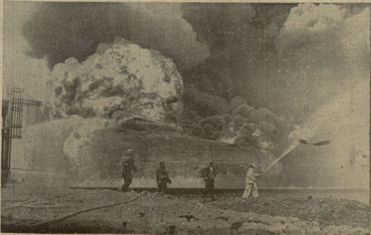
Bomberos del Sudeste, de Madrid, Pamplona, San Sebastián y otras provincias españolas y fuerzas de los Ejércitos de Tierra, Mar y Aire trabajan día y noche, a fin de terminar con el violento incendio que desde hace varios días azota la refinería de petróleos de Escombreras. — (Foto FERRER)
