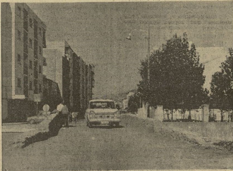
Aquí se acaba el Zaidín y acaba como verán en este puente estrecho que dificulta el paso de vehículos y peatones. Pero muy pronto terminarán los problemas, porque las obras de ensanchamiento del puente están a punto de iniciarse. ¡Mucha falta que hace! — (Foto FERRER)
