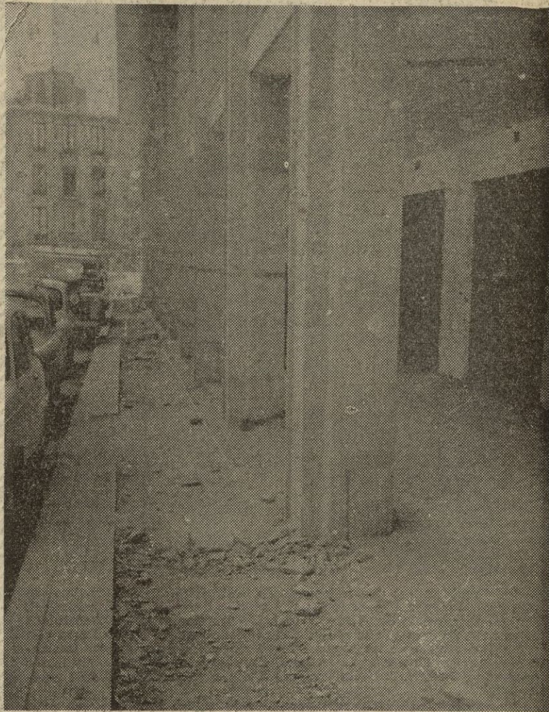
En la calle de Angel Ganivet están desapareciendo las últimas vallas. La que acaba de ser demolida pertenecía al llamado Edificio Cervantes. Ahora a pavimentar el trozo de acera que falta... y que esperamos que esté lista al cómodo circular de los peatones para las próximas fiestas del Corpus. — (Foto FERRER)
