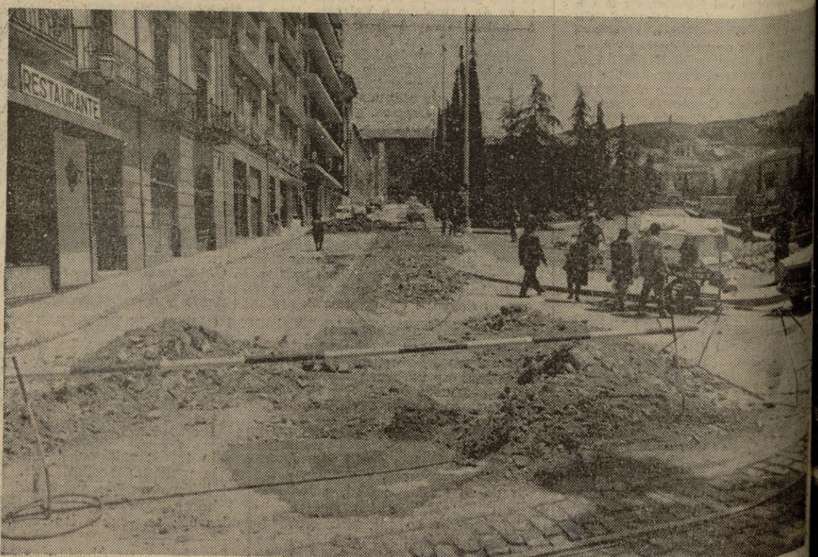
La Avenida de la Divina Pastora ha sufrido los daños de las acometidas. Pensamos que la denominación de acometida viene de acometer. Y vaya si se ha emprendido con la referida calle, que la han dejado patas arriba en el plazo de unas horas. Las enormes máquinas abrieron las zanjas y al parecer ya se han cubierto. Ahora habrá que echar un rato de paciencia para que la calle quede tan bien como estaba. El vecindario sufrirá ahora, por un tiempo, las consecuencias. — (Foto FERRER)
