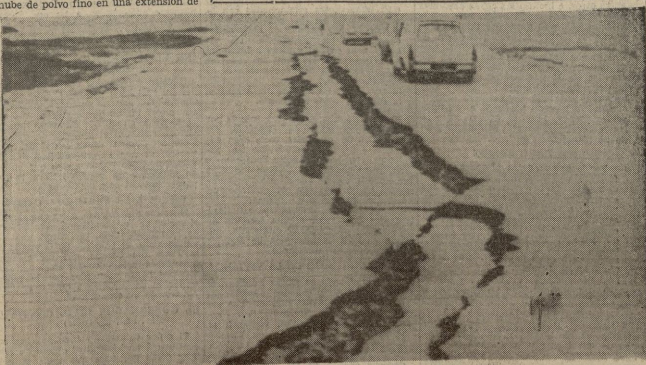
En la principal autopista Norte-Sur, del Perú, aparecen estas grandes grietas producidas por el terremoto que ha costado miles de víctimas.—(Telefoto CIFRA)
