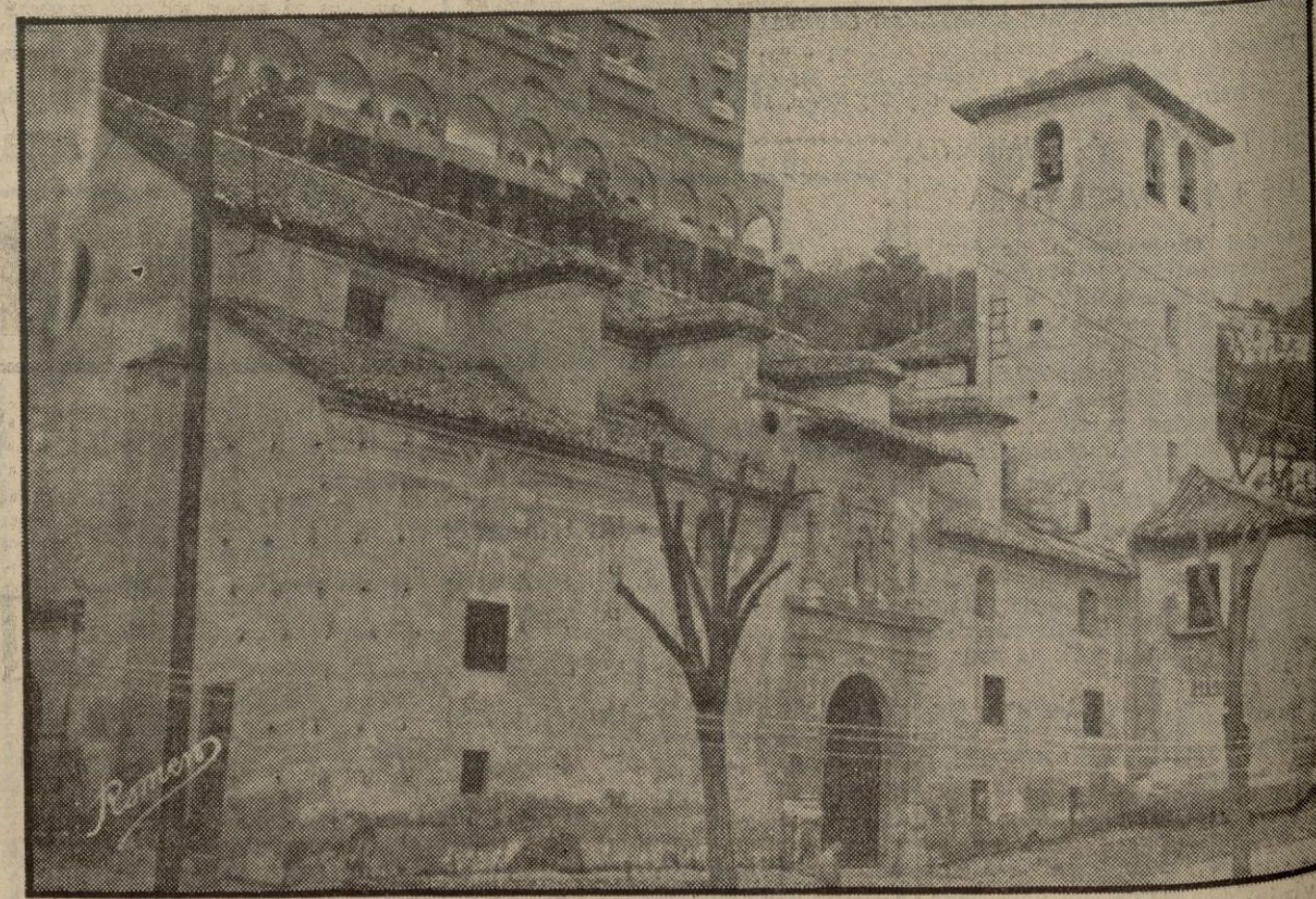
La iglesia de San Cecilio, Patrono de Granada, antes del incendio que destruyó casi la totalidad del bello monumento del siglo XVI y que está siendo reconstruida. — (Foto ARCHIVO)
