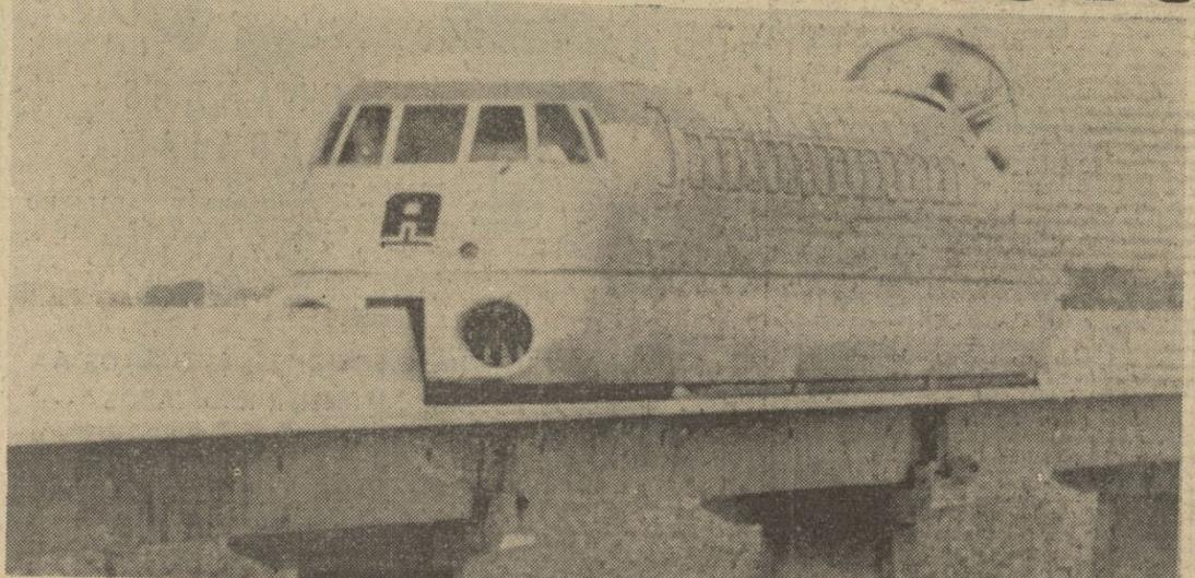
El aerotren francés fotografiado durante su presentación a la Prensa; puede alcanzar una velocidad de 280 kilómetros por hora. El aerotren corre por un gran impulso. Puede transportar de 24 a 60 pasajeros. Ha sido construido como un medio de transporte intermedio entre el avión y el tren. — (Telefoto CIFRA GRAFICA)
