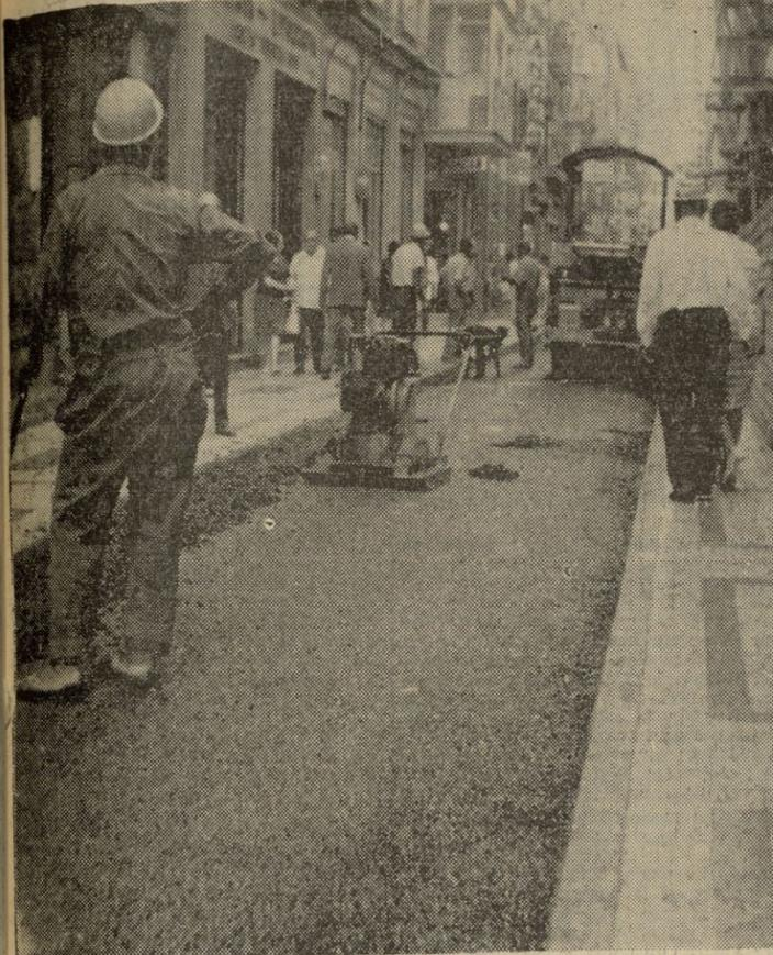
Sorpresa ayer en la calle de Mesones. Cierre de circulación y máquinas apisonadoras. ¿Qué pasa? Sencillamente, que se está dotando de una nueva capa, la de rodamiento, al asfalto de esa calle, que todos creíamos que estaba totalmente resuelta. De todas formas pensamos que la obra no va a durar más de un par de días. Ferrer ha sorprendido la máquina en su tarea, que ha avanzado bastante en sólo una jornada laboral. Así da gusto.
