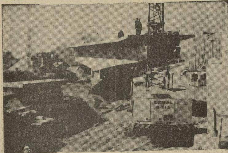
Aquí puede verse uno de los dos espigones, cada uno construido con catorce inmensos pilotes, que por un lado unirán con los estribos del puente y por otro con el gran dintel, bajo el cual surcarán las aguas del Genil.
