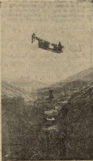
El blondin o «platillo» en su paso de una parte a otra de la futura presa, transportando maquinaria y materiales. — (Foto FERRER)
