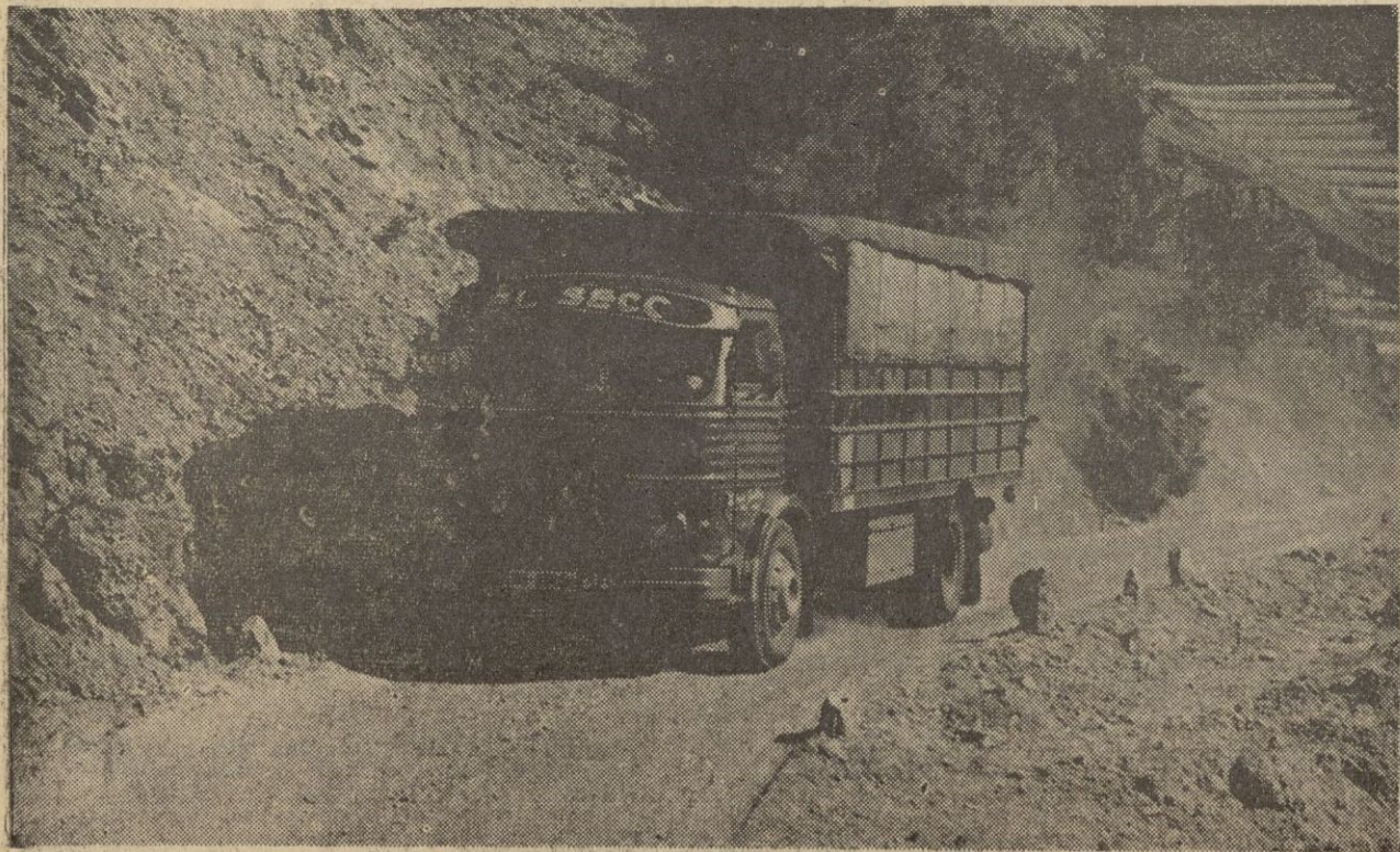
En esta fotografía puede observarse perfectamente el ancho que ha quedado de calzada. Al menos por aquí se sabe que existe carretera, porque hay otros trozos en donde, desde hace tiempo, se perdió todo vestigio de que por allí pasaba una vía importante de comunicación. — (Foto FERRER)
