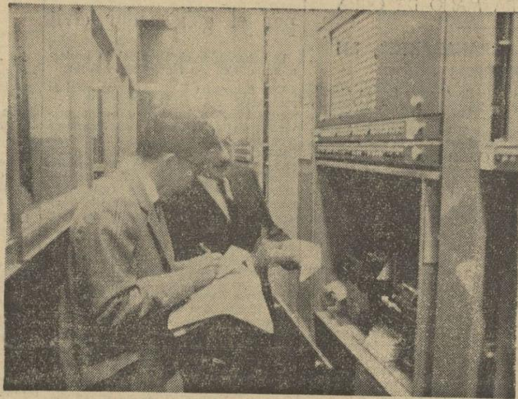
Un técnico de la Compañía explica a nuestro corresponsal el funcionamiento de la perforadora, dispositivo que, mediante tarjetas IBM, facilita con extraordinaria rapidez la localización de cualquier posible avería del sistema automático. — (Foto PEÑA)
