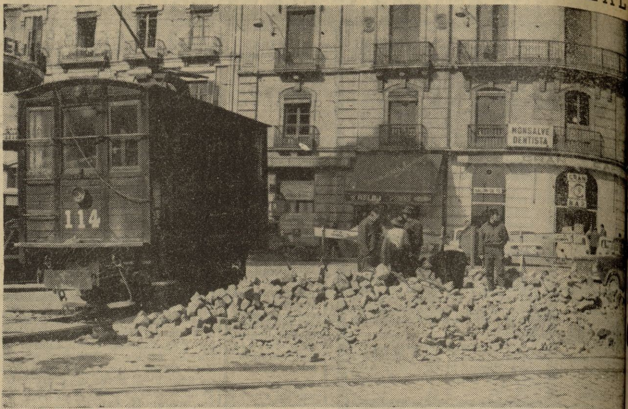
Efectivamente, continúan las obras de pavimentación en Puerta Real, y el Ayuntamiento se las está ingeniando para no cortar el tráfico, al hacerse las obras por sectores. De esta manera se forman largas caravanas de vehículos, desviándose hábilmente el tráfico en las horas «punta». — (Foto FERRER)
