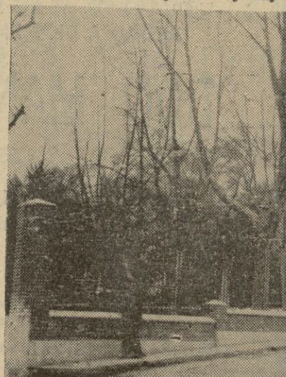
Aspecto que presenta la entrada principal al Parque de José Antonio, en donde se puede apreciar la protección metálica y de ladrillo para evitar la acción de los gamberros. — (Foto CAPARROS)
