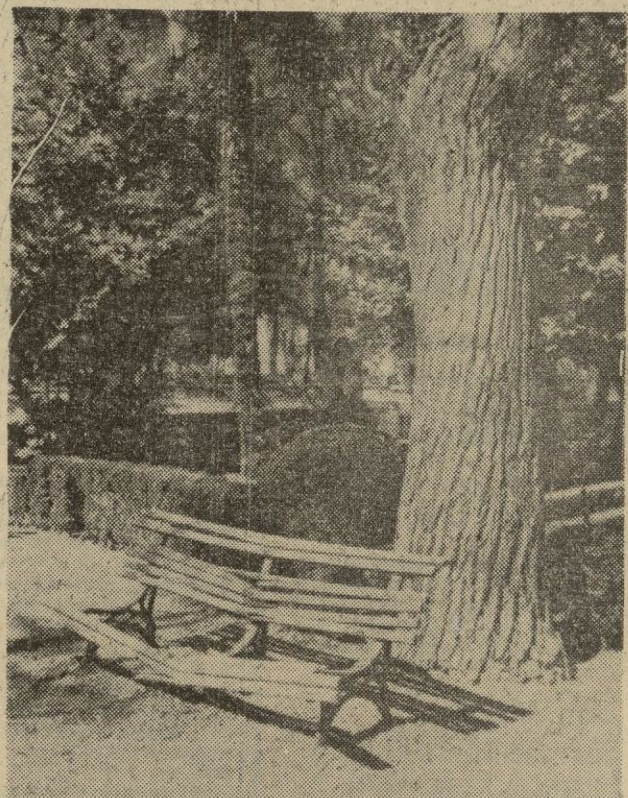
Estado en que se encuentra uno de los bancos del mencionado parque. Es sólo una muestra, porque los demás están por el mismo estilo. — (Foto CAPARROS)
