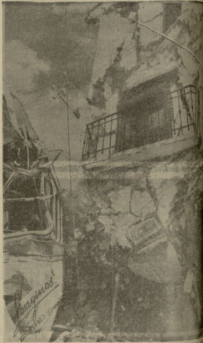
Aquí puede verse al vehículo, más conocido en aquellos lugares como "el Urtain", empotrado contra el edificio del señor Villén, momentos antes que se derrumbase a consecuencia del terrible golpe recibido en su estructura. — (Foto LONGINOS)
