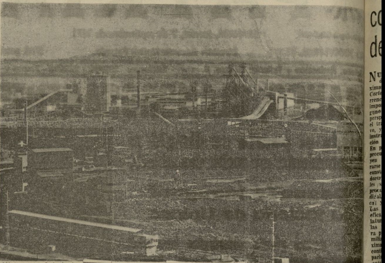
Vista general de la factoría de Uninsa y los parques de coque y mineral en primer término. También pueden verse los hornos altos y el resto de las instalaciones. — (Foto PYRE A)
