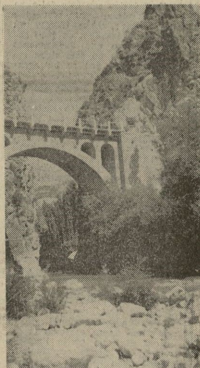
Puente de "El Portillo", sobre el truchero río Castril.
