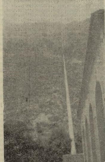
Tubería por donde se conduce el salto de agua que se utiliza en la fábrica de la Compañía Sevillana de Electricidad.
