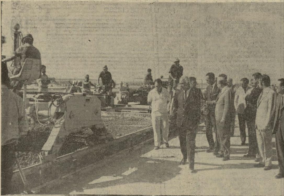
La pista de estacionamiento está muy avanzada. Será de hormigón y media docena de máquinas, que se surten de una docena de volquetes y un centenar de operarios laboran sin descanso en la tarea. Un paso más para que el aeropuerto esté concluido en la próxima primavera.—(Foto FERRER)
