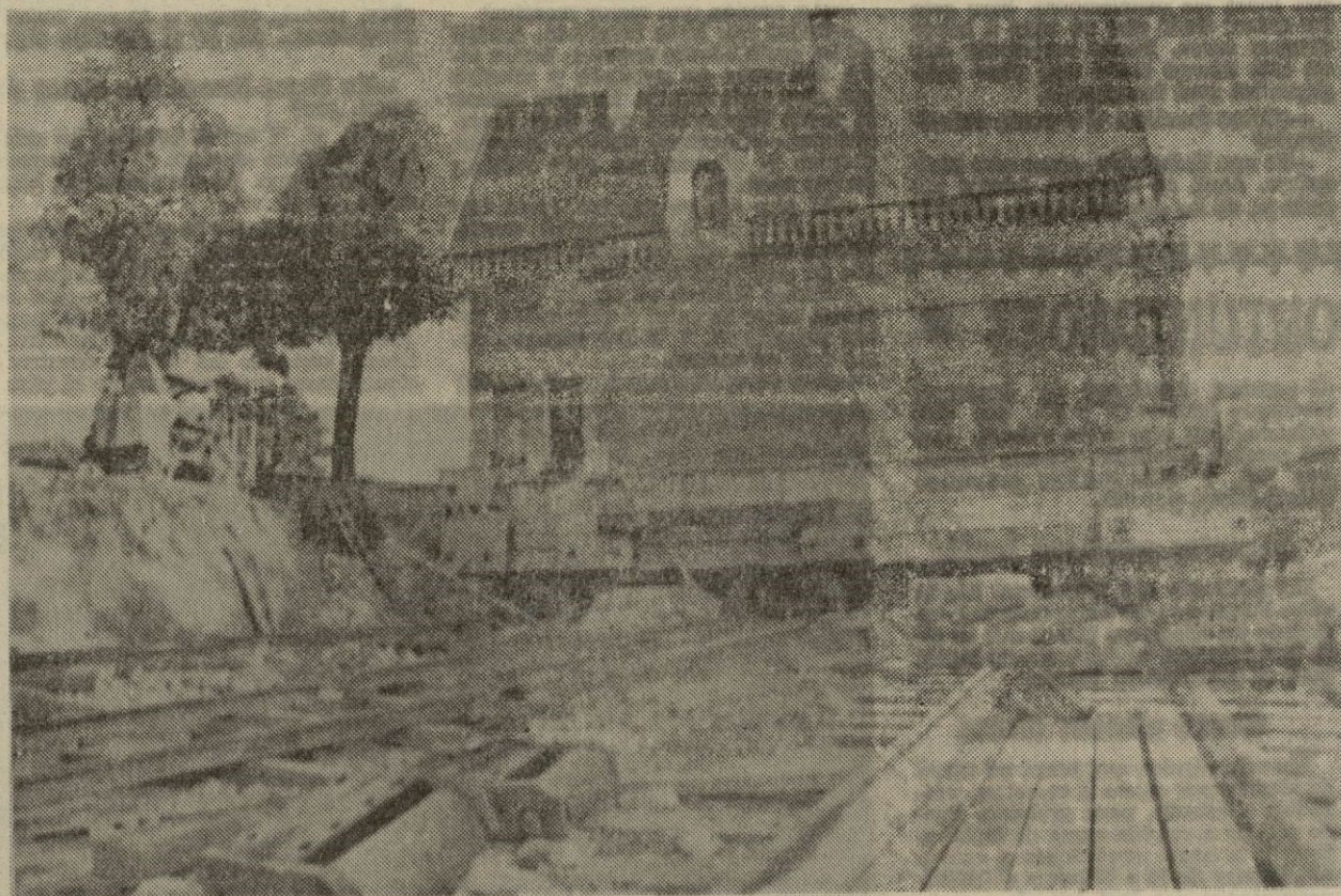
Una magnífica casa de ladrillo y cemento ha sido trasladada de lugar por la que se van a instalar las vías del ferrocarril. Se encuentra situada en una zona residencial y dentro de poco volverá a ser una casa firme. — (Telefoto CIFRA GRAFICA)
