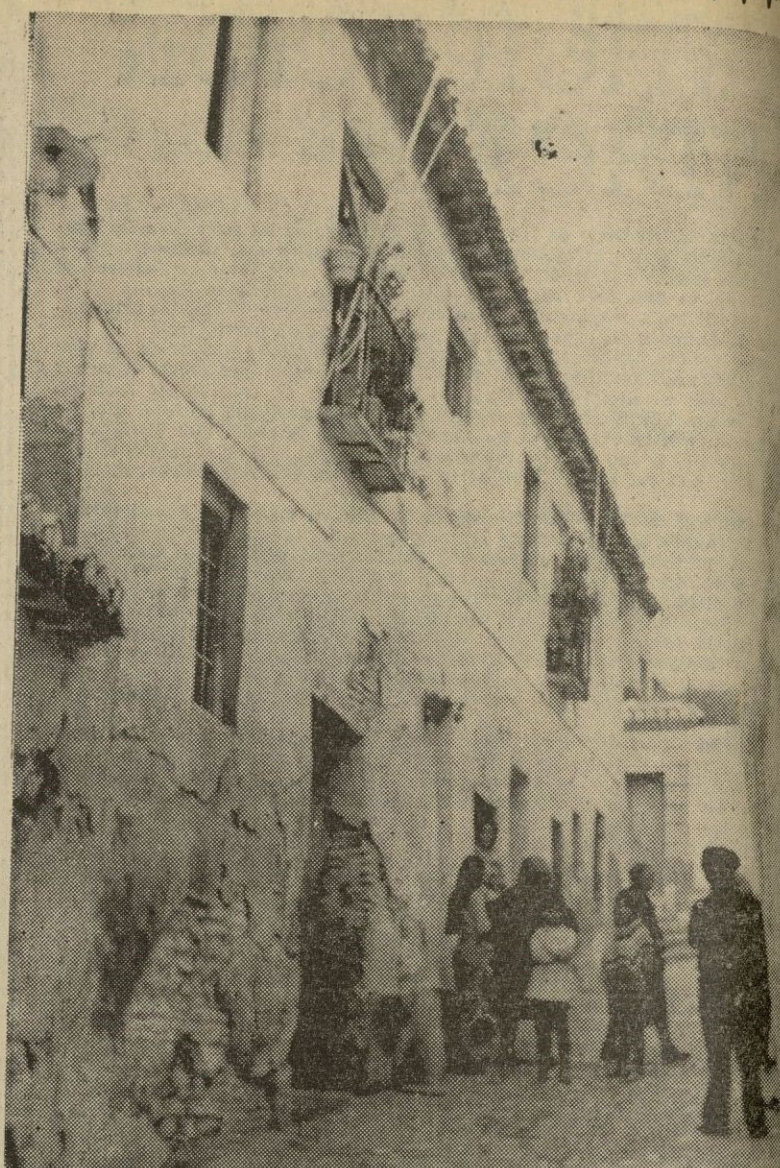
Esta es la casa número 13 de la calle San José Alta, que ha sido declarada en ruinas y debe ser desalojada cuanto antes. Es una de las muchas construcciones antiguas que hay en la típica barriada del Albaicín. — (Foto FERRER)
