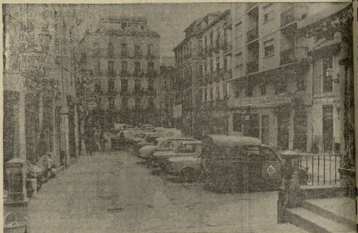
Estado actual de la plaza resultante de la demolición de las antiguas naves de la pescadería. Efectivamente, la obra es necesaria y urgente. Por eso ha sido tan bien acogida.—(Foto FERRER)
