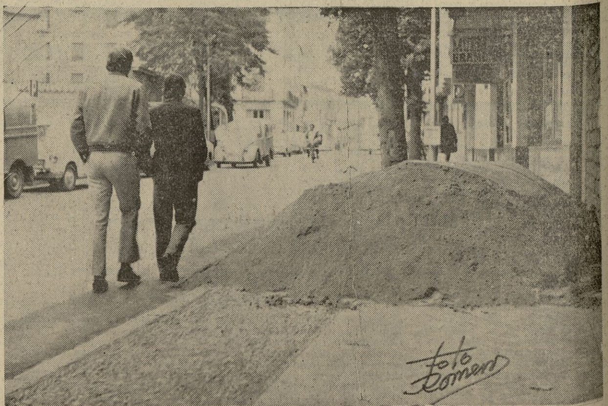
La escena se repite todos los días, en las calles más céntricas, en los barrios más extremos, allí donde se realice una obra. Llega el camión con la arena y la descarga en la puerta del edificio que se repara o se construye, y allí permanece, en plena acera, horas y horas, a veces días y días. Consecuencia: que el transeúnte tiene que dar un rodeo y bajarse a la calzada, con el consiguiente peligro de que cualquiera de los autobuses o automóviles que por allí circulan se lo lleve por delante, sobre todo si es un niño o un anciano. Esta arena amontonada en plena acera es una valla que impide el paso al transeúnte y que las autoridades municipales debieran evitar, con una mayor vigilancia. — (Foto ROMERO)
