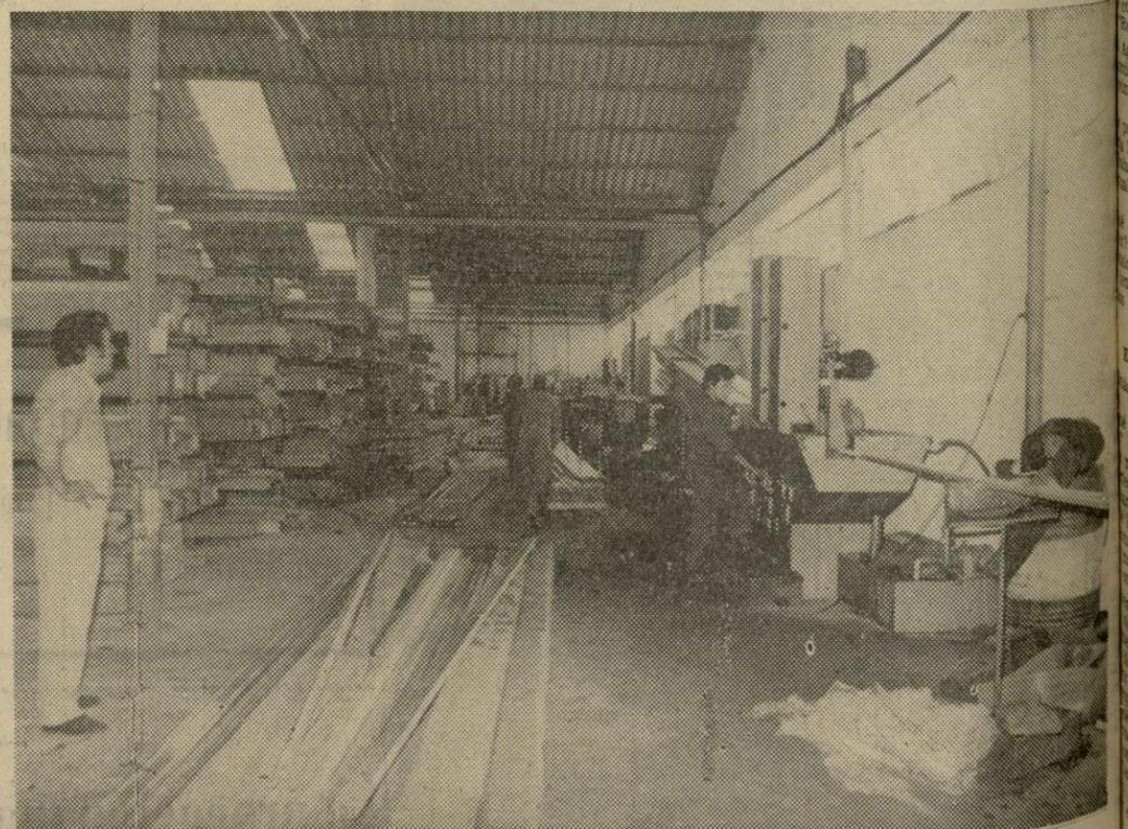
Sección de pulido mecánico y automático, consiguiendo un uniforme y perfecto acabado en toda la superficie del perfil.
