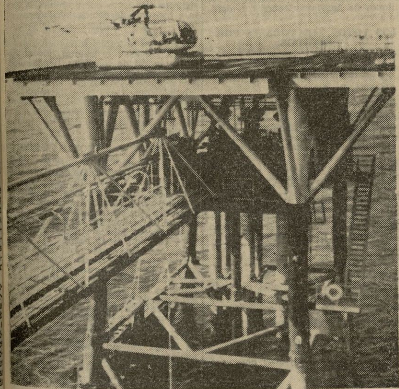
En Amposta (Tarragona), vista general del pozo «Amposta-Marino C-1» donde se llevan a cabo los trabajos de montaje de la maquinaria necesaria para la producción petrolífera sobre las ya instaladas plataformas, situadas a veinte metros sobre el nivel del mar. — (Telefoto CIFA GRAFICA)
