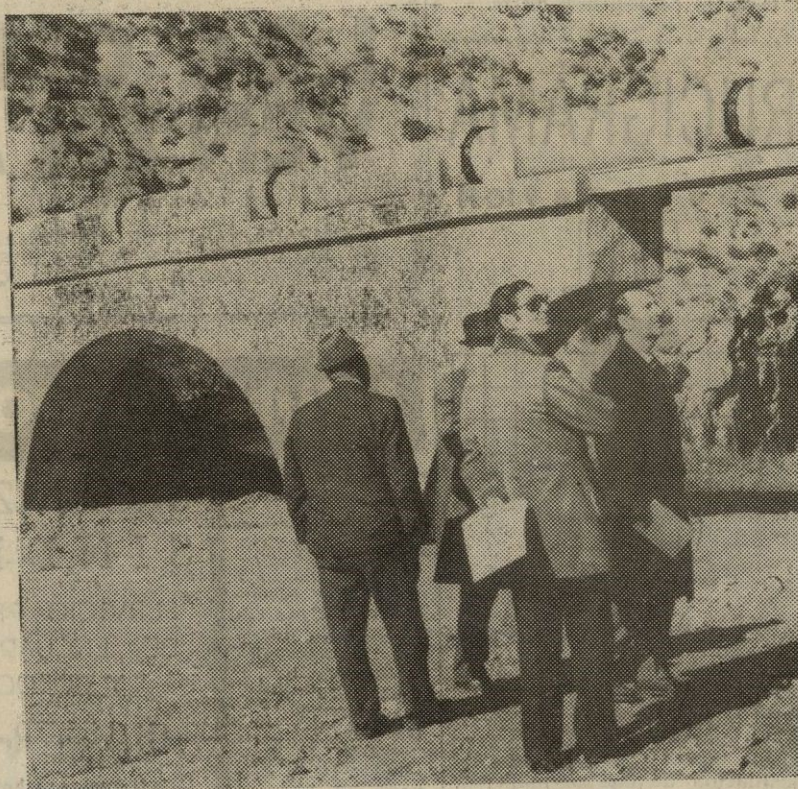
Este acueducto se destruyó por un corrimiento de tierras en el barranco de Cejés, hace unos años. Ahora se va a dotar de una nueva conducción de hierro y mayor capacidad. — (Foto FERRER)
