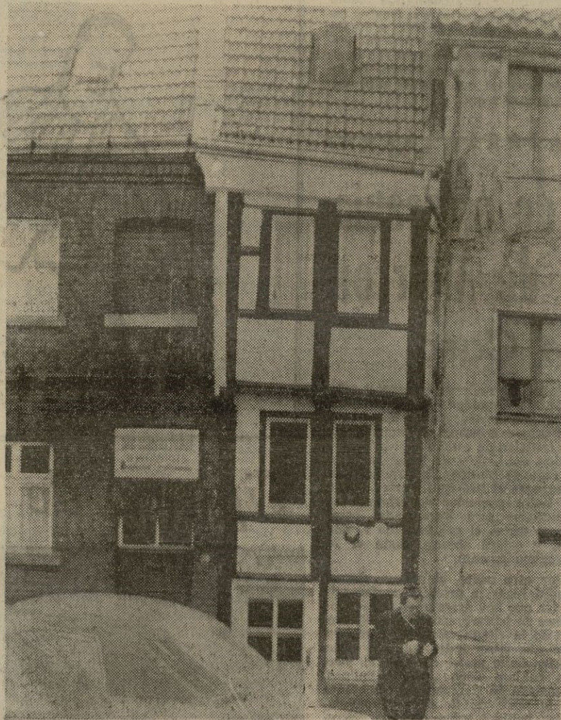
Esta pequeña casa, la más estrecha de Alemania, tiene una anchura de sólo dos metros y medio y se encuentra en el viejo distrito de Essen. Construida en el año 1336, actualmente se encuentra habitada por un joven matrimonio de estudiantes. — (Telefoto AP-EUROPA PRESS)
