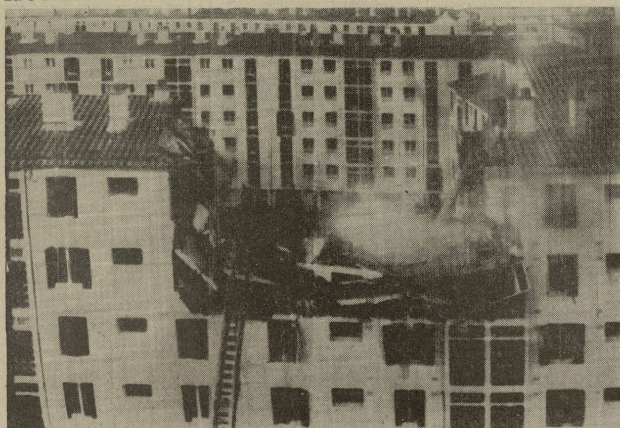
En Perpignan (Francia), tres apartamentos han volado por los aires, a causa de una explosión de gas en un inmueble de cuatro plantas del barrio de Moulin-a-Vet, causando el derrumbamiento de un ala del edificio. Entre los escombros fueron hallados dos cadáveres, pero se piensa que hay otras personas aprisionadas. — (Telefoto PYRESA)
