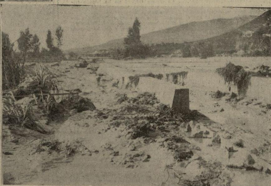
Los daños en la presa de Vélez Benaudalla son evidentes, así como el destrozo del puente de hierro sobre el Guadalfeo, que se lo llevó la corriente impetuosa. En la otra fotografía, abajo, a la derecha, se aprecia el estado de la carretera del Azud de Vélez. — (Fotos LUX)
