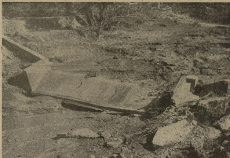
El dique de contención del río, a pocos metros del puente, se fue entero y destruido. En este lamentable estado quedó.
