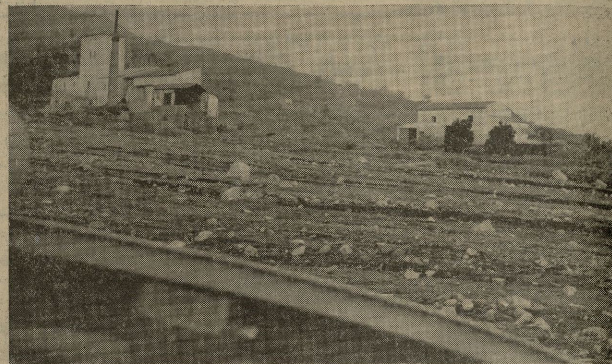
Dos edificios de los que solamente queda la fachada. Uno de ellos era la fábrica de alcoholes y el otro, una granja. Hoy están destruidos en mitad de lo que fue el cauce de la riada.
