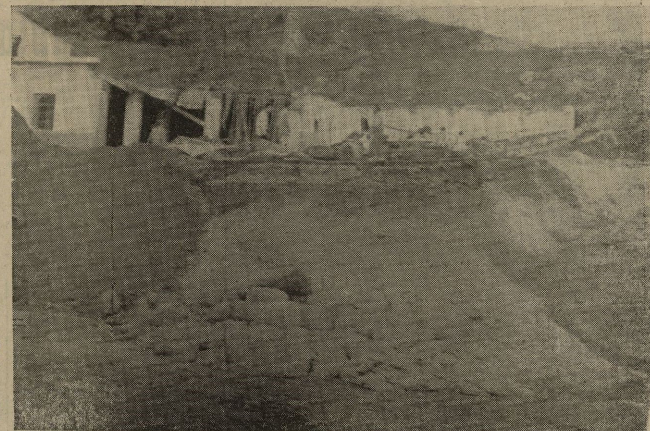
Esta casa se vino abajo. Está a mitad de camino entre Albuñol y La Rábita. Encima del corral apareció un camión.
