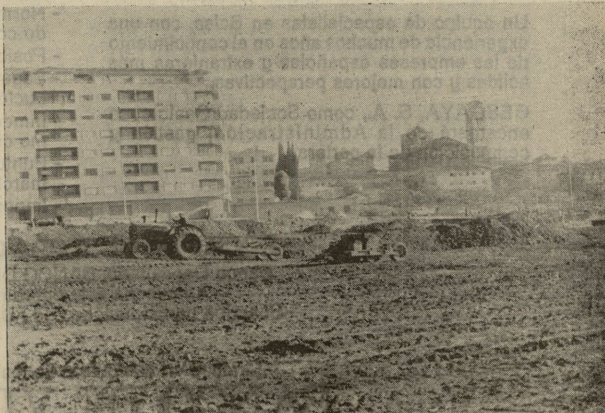
Los trabajos para la creación de instalaciones deportivas y un campo de fútbol van adelantados en el Polígono Universitario, en los terrenos adyacentes a los comedores. Dos tractores y dos camiones están siendo utilizados en la nivelación del terreno. Este campo vendrá sin duda a llenar una gran necesidad de nuestra Universidad. — (Foto J. M.)
