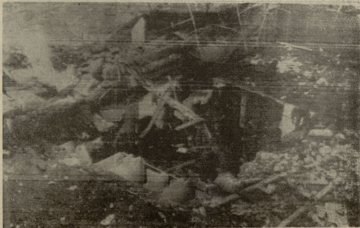
Estado en que quedó el suelo que ocupaba la galería de duchas en unas instalaciones de tenis que volaron por una explosión de gas en Barcelona. — (Telefoto-CIFRA GRAFICA)
