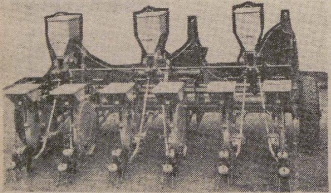
LA UNICA SEMBRADORA-ABONADORA MECANICA DE PRECISION DISEÑADA EXCLUSIVAMENTE PARA LA SIEMBRA DE REMOLACHA.
