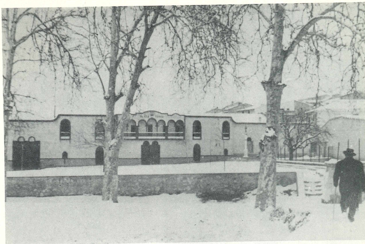
N.º 25. — Plaza de Toros. Fachada.
