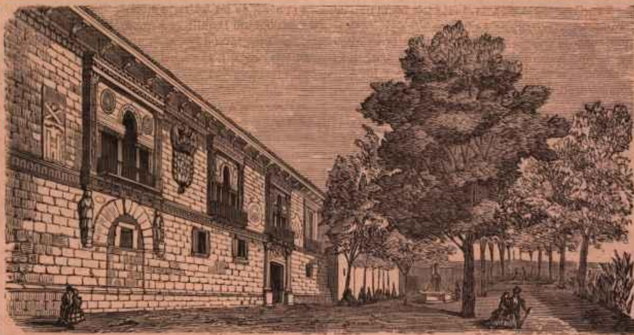
Exterior de la cárcel de Baza.
