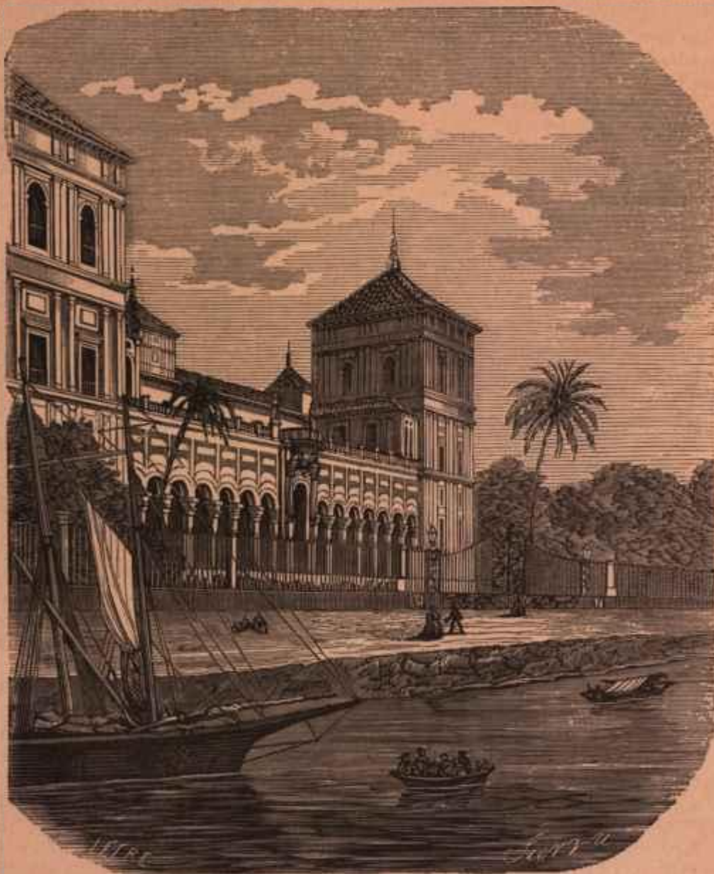
Vista del palacio de San Telmo en Sevilla.
