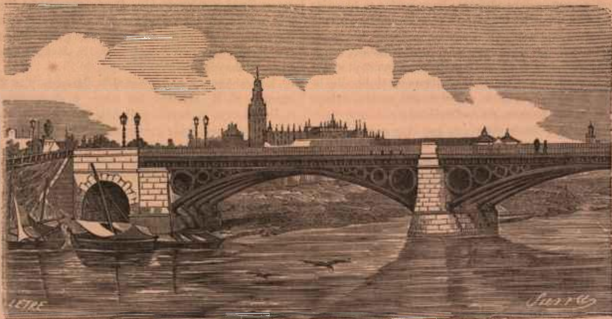
Puente de hierro de Sevilla.
