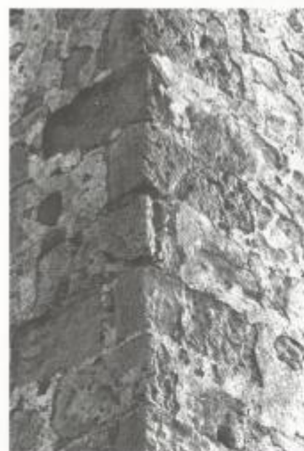
● Detalle de la Torre del Xaral. Refuerzo de esquina con sillares. Foto: C. Olano.
