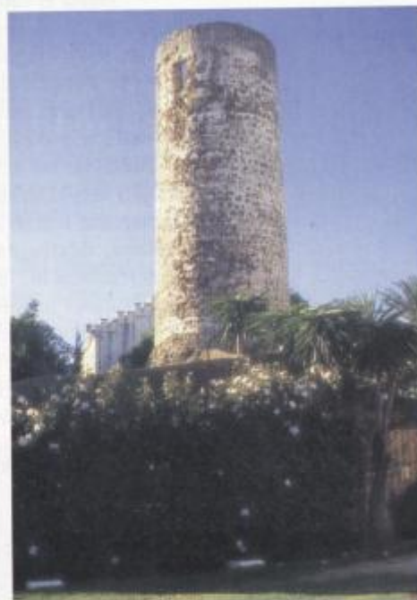
● Torre de Baños, Estepona. Foto: J. Macías.
