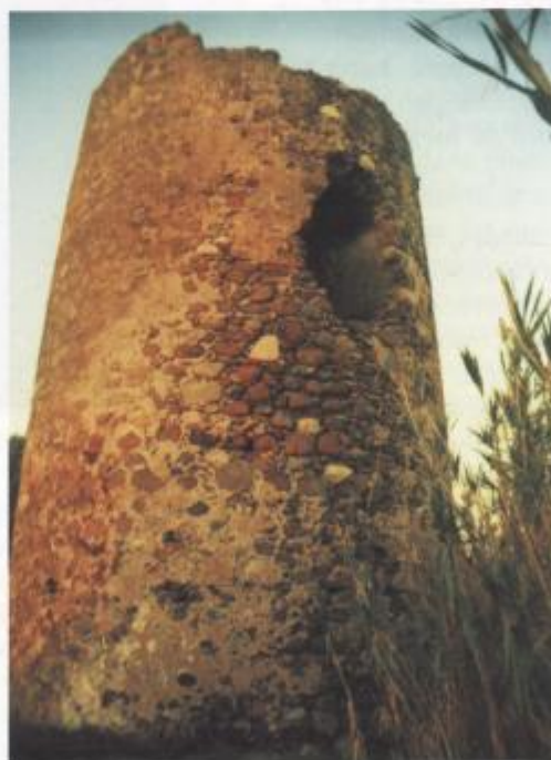
● Mampostería de la Torre Velerín. Estepona. Foto: J. Macías.
