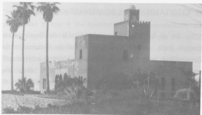
Estado del edificio después de la intervención de los años 80.
