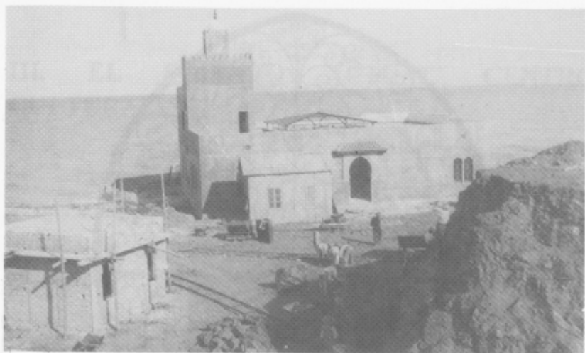
Vista de las obras de construcción en 1934.
