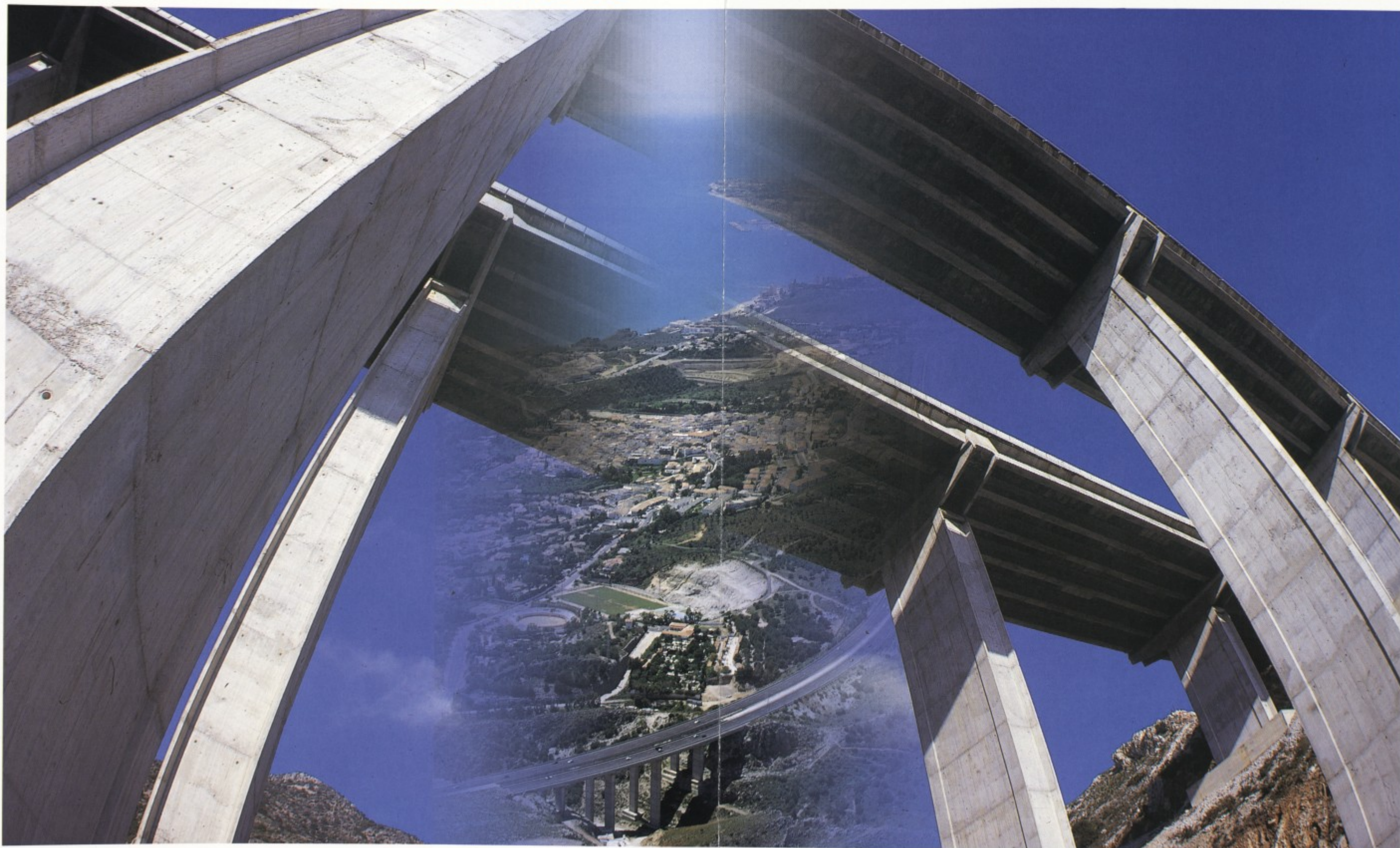
Viaducto de la autovía a su paso por Benalmádena
