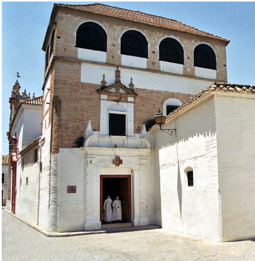
Lám. 16. Fachada principal y torreón mirador. Convento de "Las Marroquies". Écija. Año 1764 (Foto de 1999).
