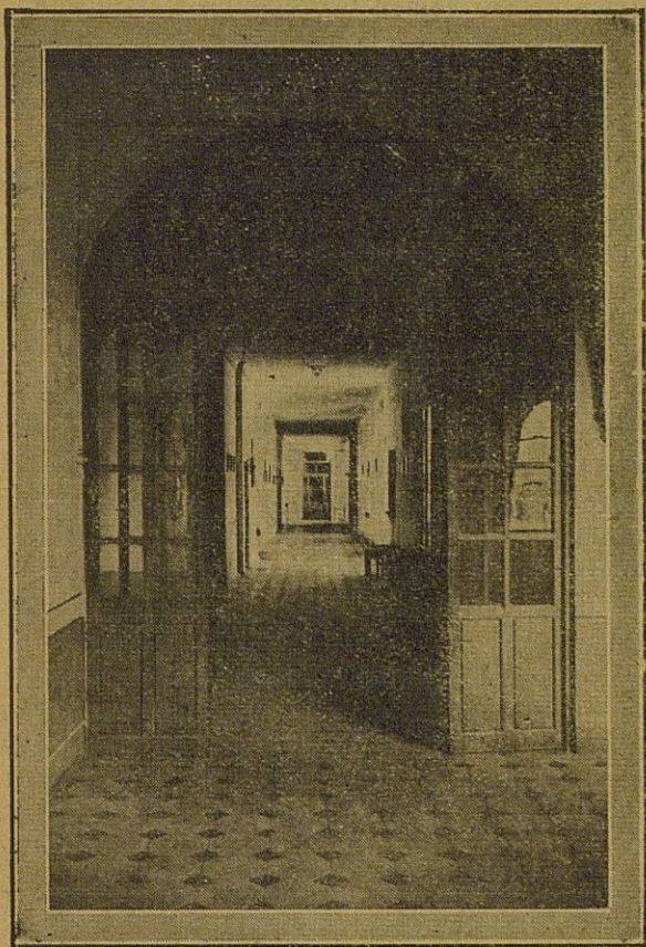
Una de las galerías.
