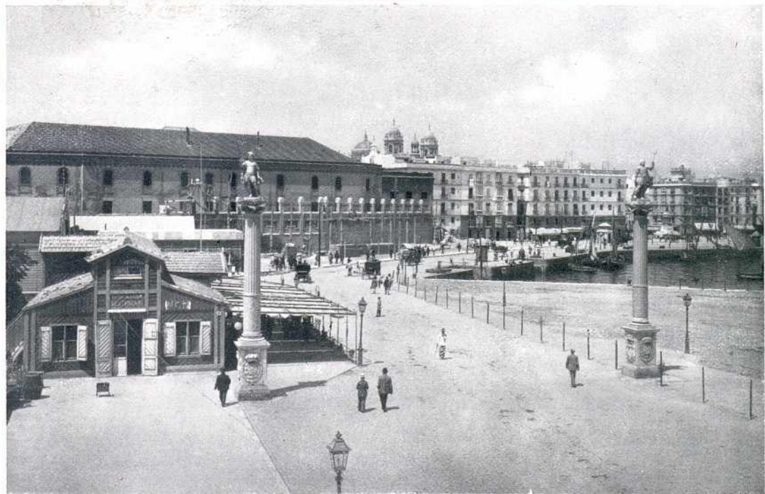
En primer término aparecen las dos columnas con los patronos de Cádiz, San Germán y San Servando, y la fábrica de tabacos al fondo.
