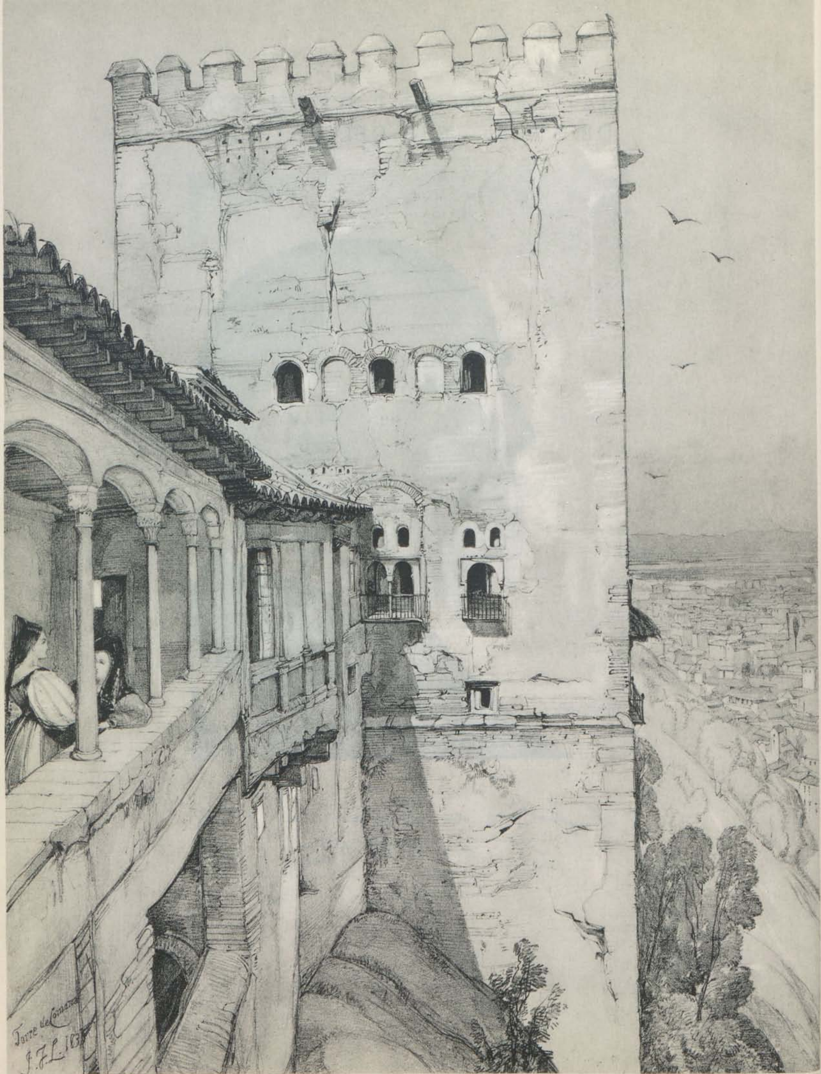
TORRE DE COMARES. (John F. Lewis, 1833.)
