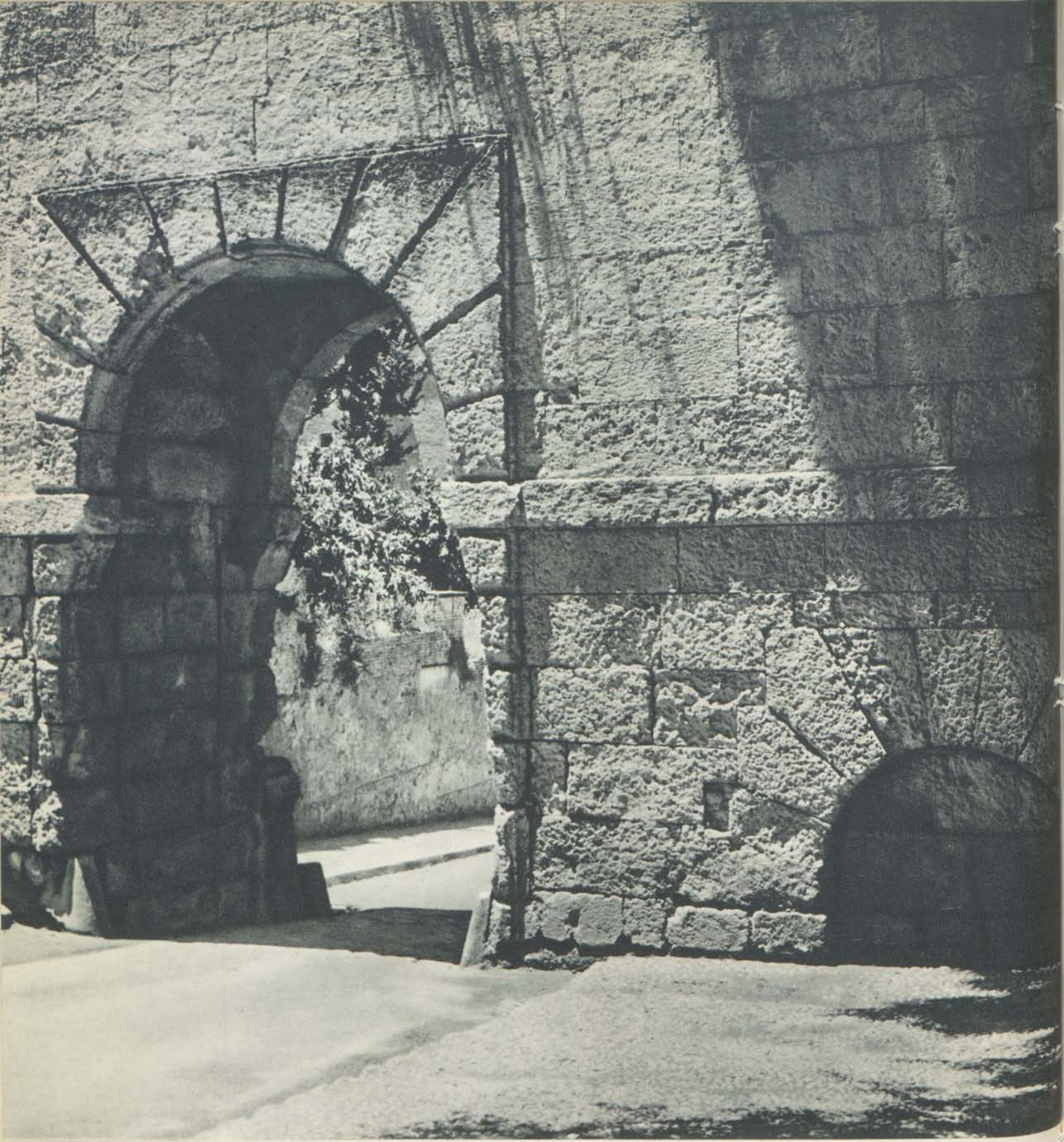
PUERTA DE LA GRANADA. PARTE INTERNA.
