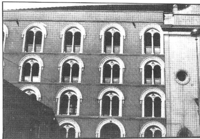
FACHADA COLEGIO DE LA PRESENTACION.
