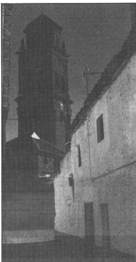
Torre de la Iglesia.
