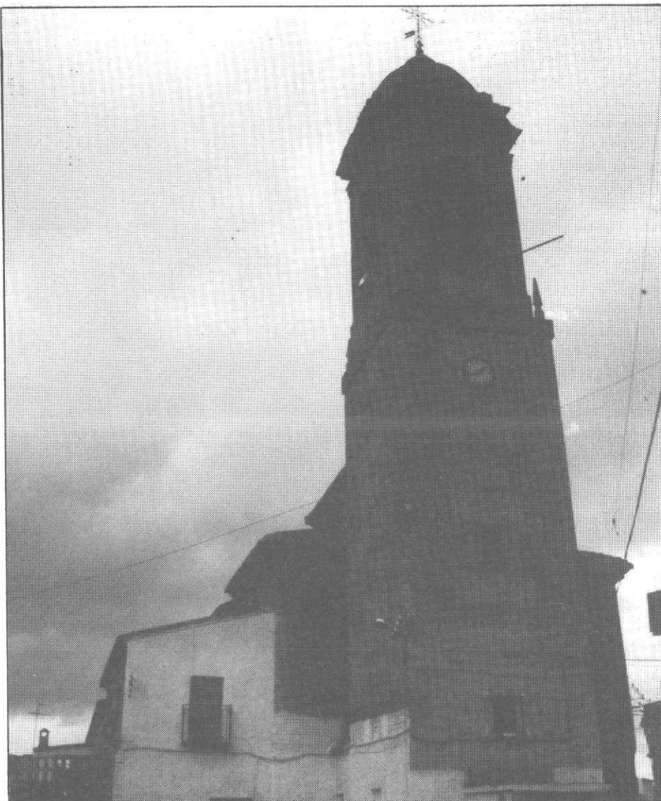
Torre de la Iglesia. Foto: Picaro.
