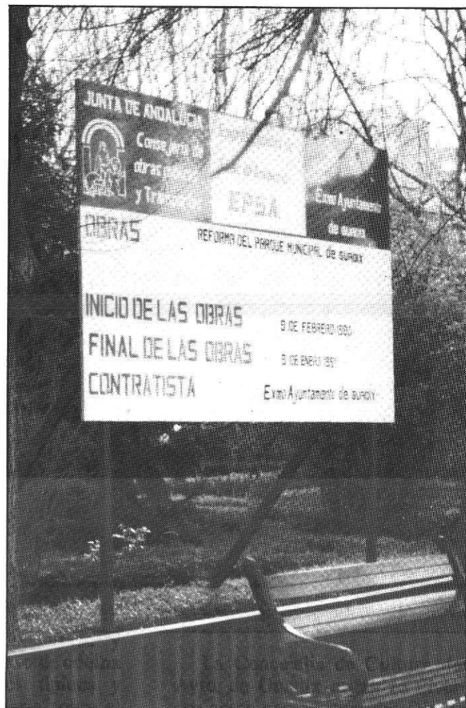
El Parque en obras. Foto Molas.
