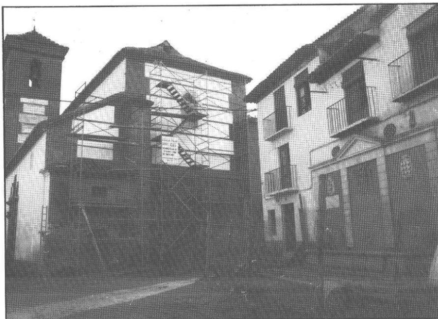
Rehabilitación de la Plaza y Caño de Santa Ana.
