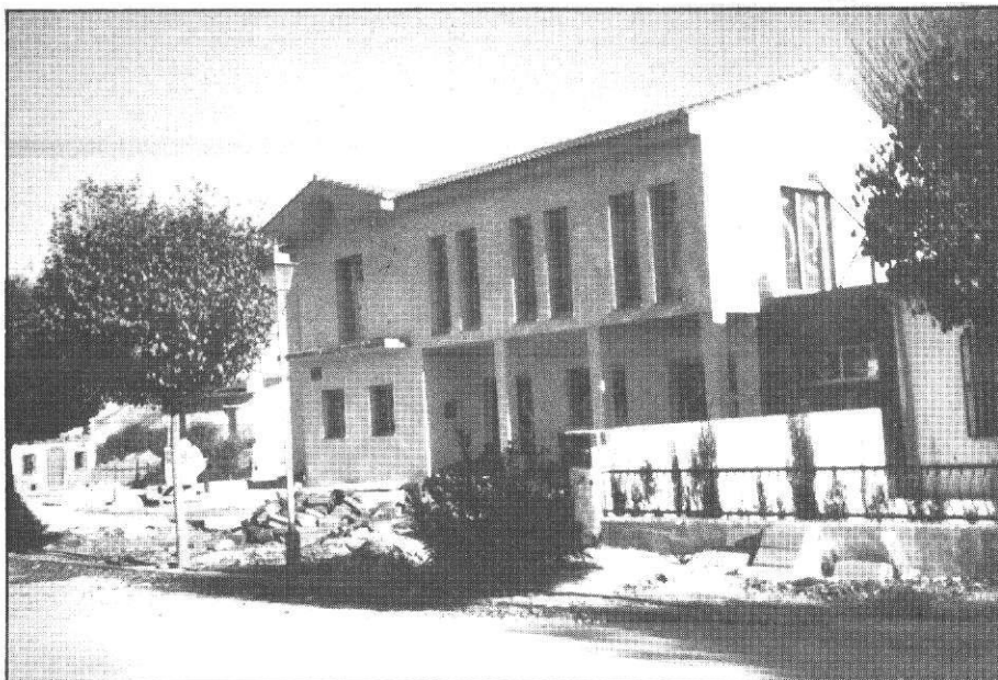
El edificio más moderno, destinado a Ayuntamiento y Club de Ancianos. En construcción.
