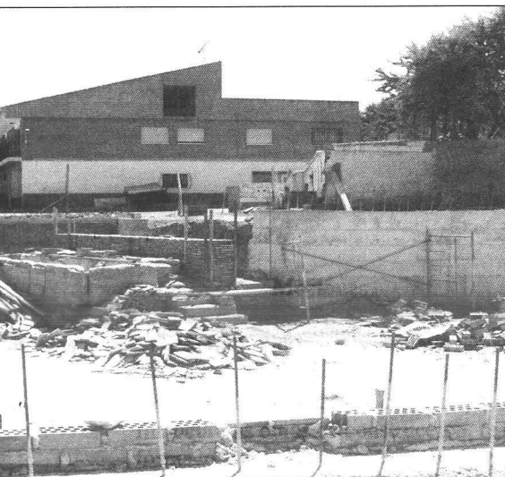
Obras en el Caño de San Antón.
